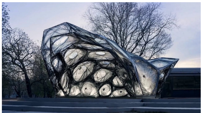
Pavillon de recherche 2013-2014 http://icd.uni-stuttgart.de/?p=11187 Modèle biologique : élytre de coléoptère
