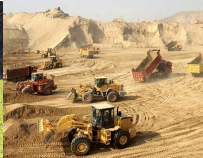
Terrassement – Arasement d'une colline en Chine @ Le Monde
