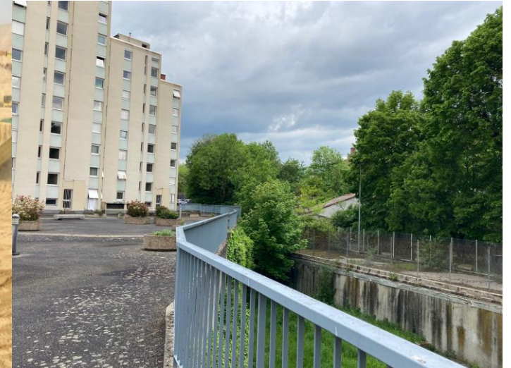
Canalisation de la rivière du Furan, Saint-Etienne @ Anne Gaillard
