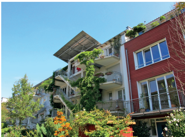
Écoquartier Vauban, Fribourg-en-Brigsau Noue jardin, façades vertes CC Mangan02
